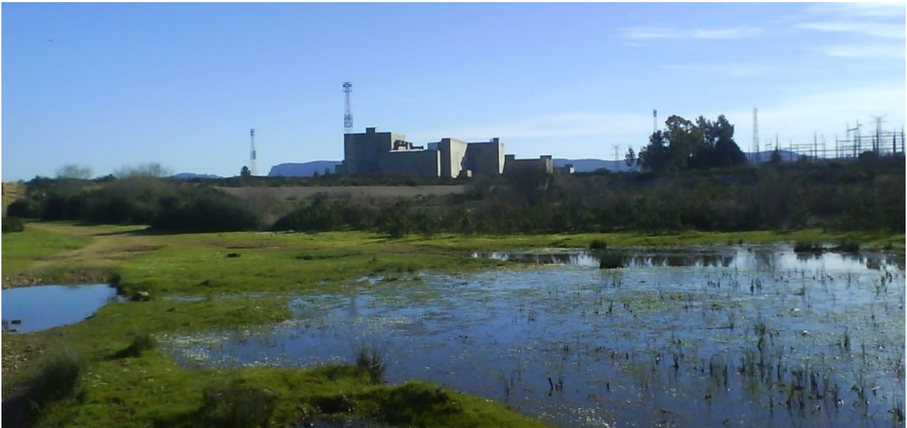
Central Nuclear desmantelada de Valdecaballeros en la Siberia Extremeña, Badajoz, 2007. Foto por Pablo de Soto.
